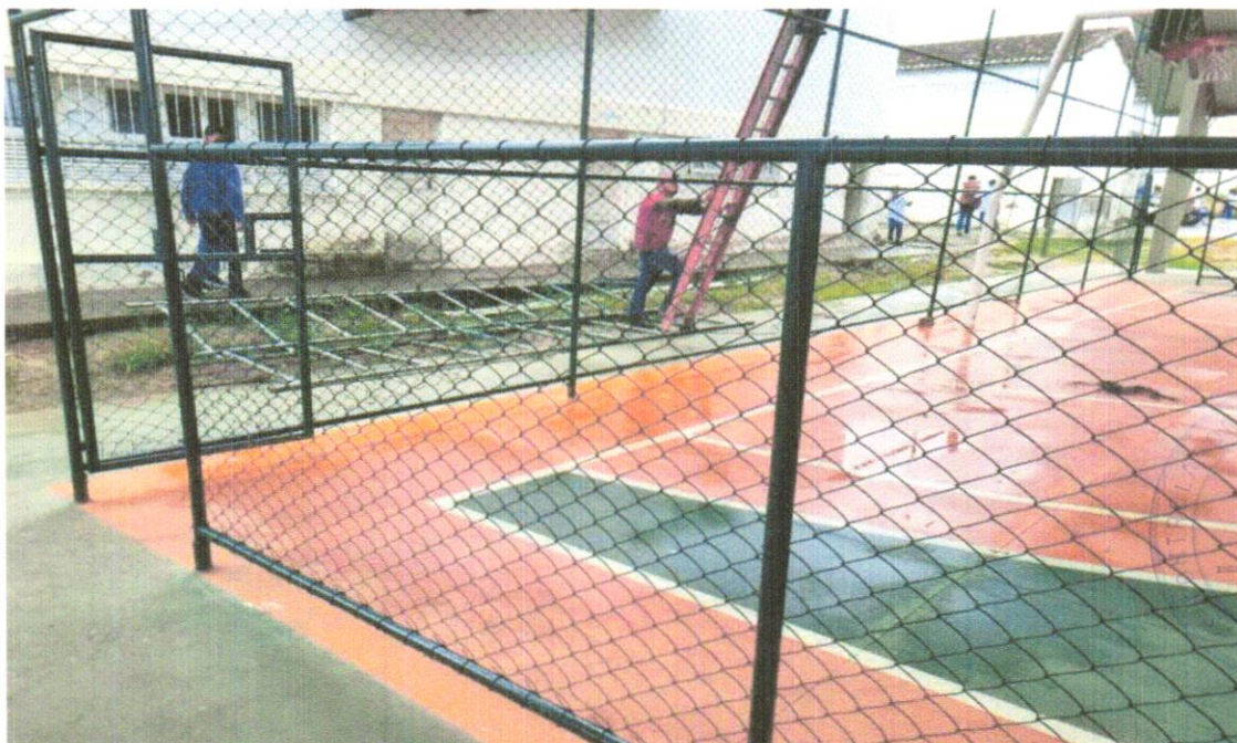
Foto 10 – INSTALAÇÃO DO ALAMBRADO LATERAL
