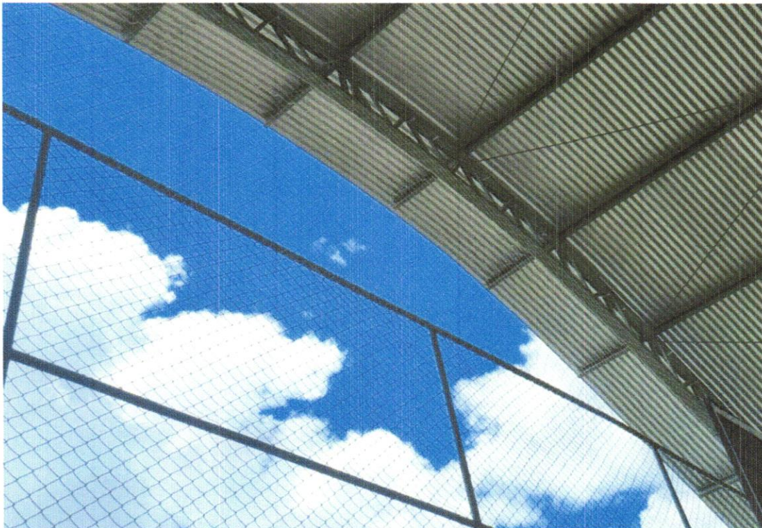
Foto 12 – INSTALAÇÃO DA REDE DE NYLON
