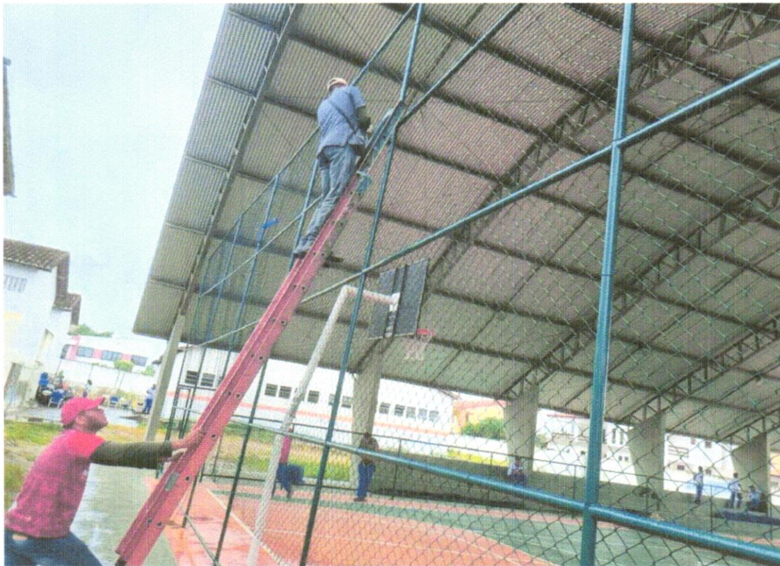
Foto 09 – INSTALAÇÃO DO ALAMBRADO FRONTAL
