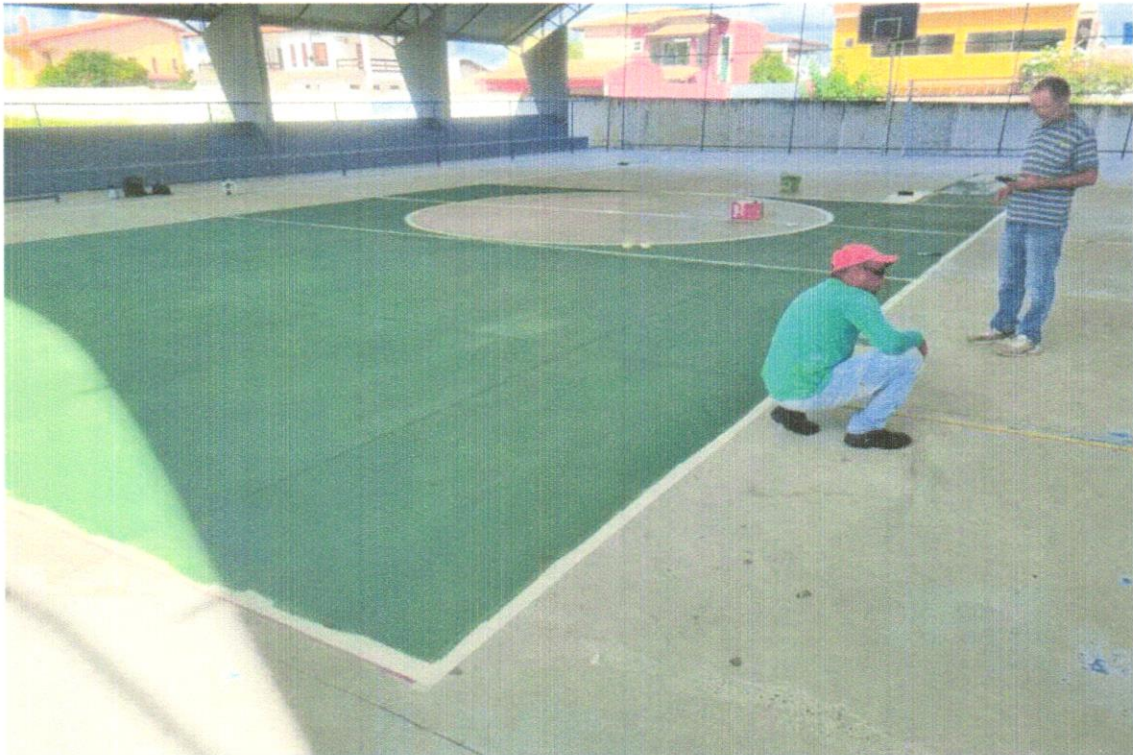
Foto 05 – DEMARCAÇÃO E PINTURA DO PISO DA QUADRA
