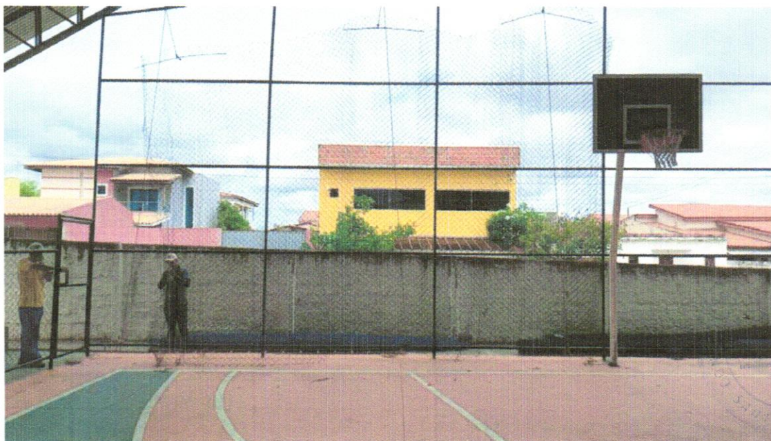
Foto 08 – INSTALAÇÃO DE ALAMBRADO FUNDO
