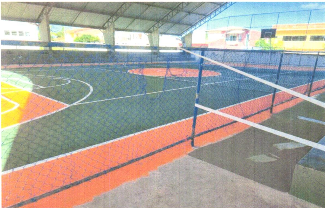
Foto 06 – PINTURA DO PISO E ARQUIBANCADA
