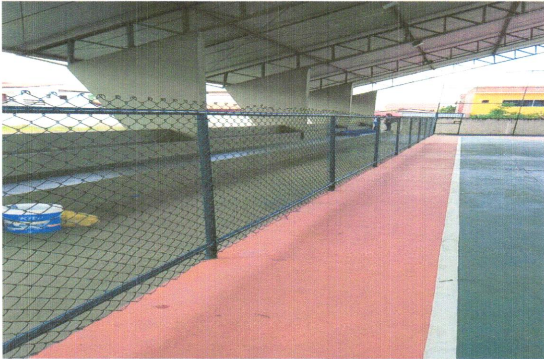
Foto 11 – INSTALAÇÃO DO ALAMBRADO LATERAL
