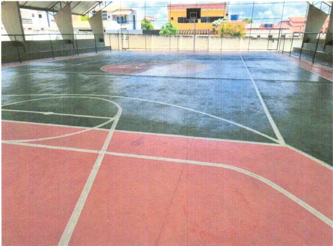
Foto 07 – PINTURA DO PISO DA QUADRA
