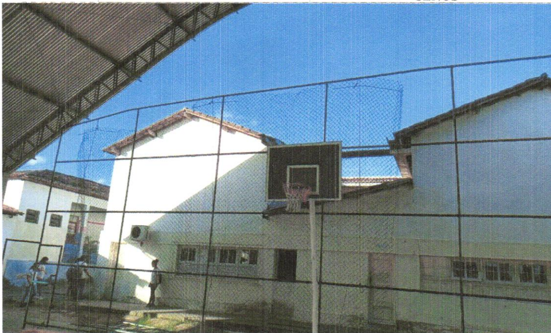
Foto 01 – REMOÇÃO DE ALAMBRADO FRONTAL
